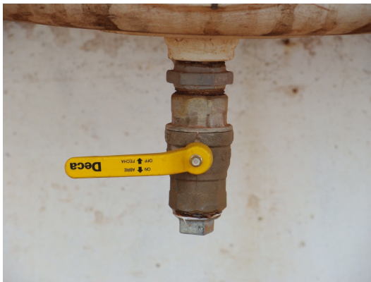
Figuras 8/9 - Drenagem semanal dos tanques de armazenamento de combustível
