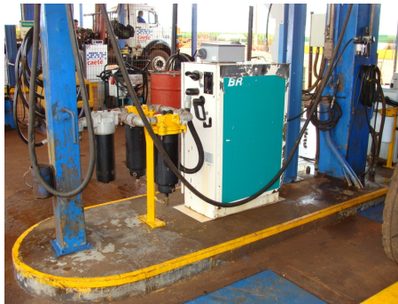
Figuras 33/33 - Filtros coalescentes/separadores/micrônicos em bomba de dispensa e em comboio de abastecimento
