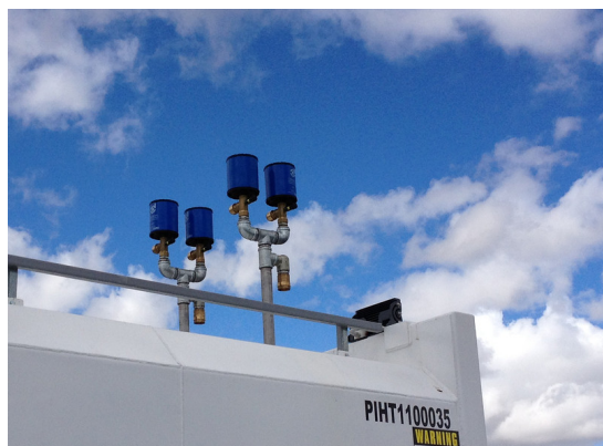
Figuras 24/25 - Filtros dessecantes em tubos de respiro
