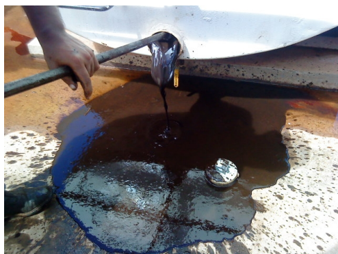
Figuras 14/15 – Lastro não drenado de fundo de tanque de combustível
