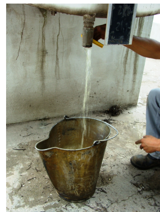
Figuras 10/11 – Remoção de água livre decantada
