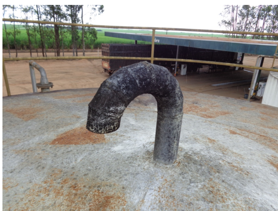
Figuras 30/31 - Filtros em tubos de respiro são de fundamental importância
