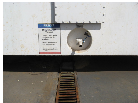
Figuras 8/9 - Drenagem semanal dos tanques de armazenamento de combustível
