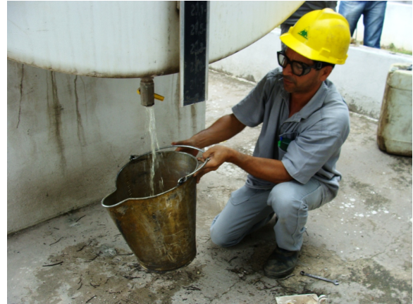
Figuras 26/27 - Procedimentos de recebimento de caminhões-tanque e drenagem de tanques de armazenamento de combustível
