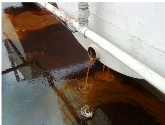
Figuras 10/11 – Remoção de água livre decantada
